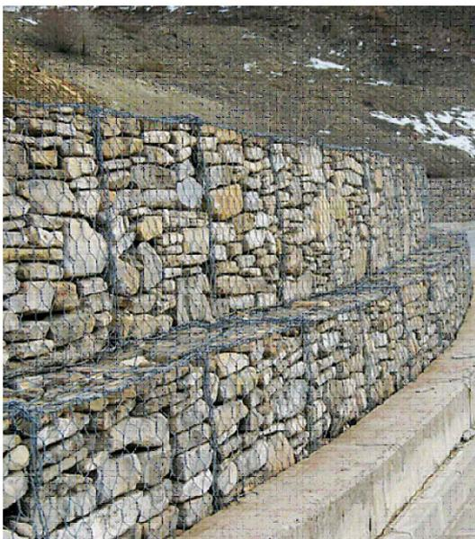
I box sono strutture realizzate con rete metallica a doppia torsione con maglia esagonale. Riempiti con pietre e/o ciottoli, vengono impiegati per opere di conservazione del suolo e nelle sistemazioni idrogeologiche.
